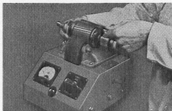
Fig. 3-17. Het beproeven van het anker
